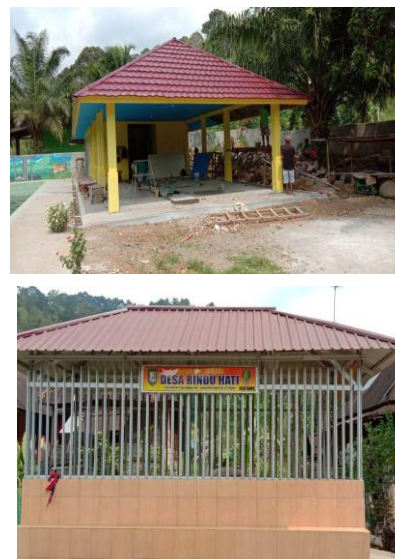
Gambar 3. Pembangunan Sarana Prasarana Olahraga (Program Pembangunan Desa)
